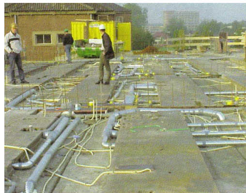
Fig. 5.3. Wing-vloer tijdens de uitvoering; Ref. [26].
