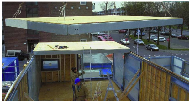
Fig. 5.7. Plaatsing staalframe vloerelement; Ref. [28].
