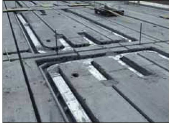
Fig. 5.2. VBI-leidingvloer tijdens uitvoering; Ref. [26].
