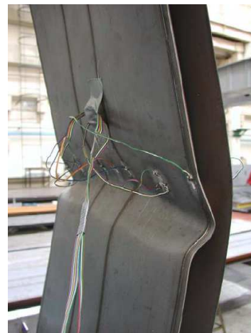
Fig. 4.19. Lokaal bezwijkmechanisme; Ref. [19].
