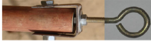
Figure 3.5: Dome connector (Kushwaha, 2012)
