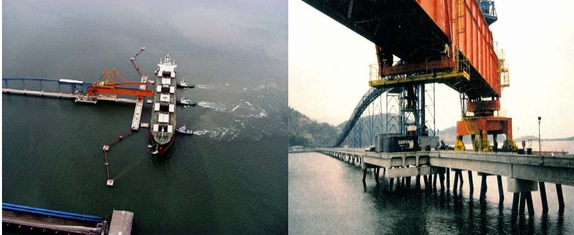
Figuur 1.3: Trestle brug tussen het vaste land en een offshore constructie [2]
