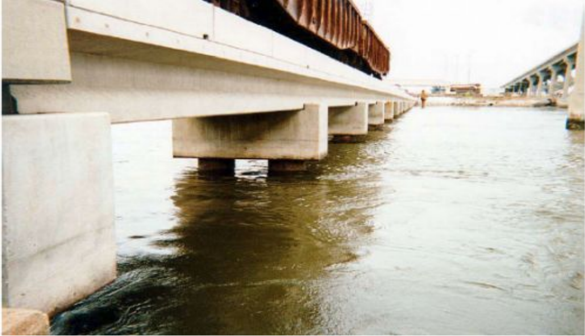
Figuur 1.7: Beaufort and Morehead spoorweg trestle brug over de rivier van Nieuwpoort tussen stad Morehead en Radioeiland. Deze trestle brug bestaat uit: geprefabriceerde T-voorgespanliggers, gewapende betonnen prefabkespen, en staalbeton palen. De palen bestaan uit: stalen buispalen van 600 mm die zijn beschermd door betonnen cilinderpalen van 900 mm [4]
