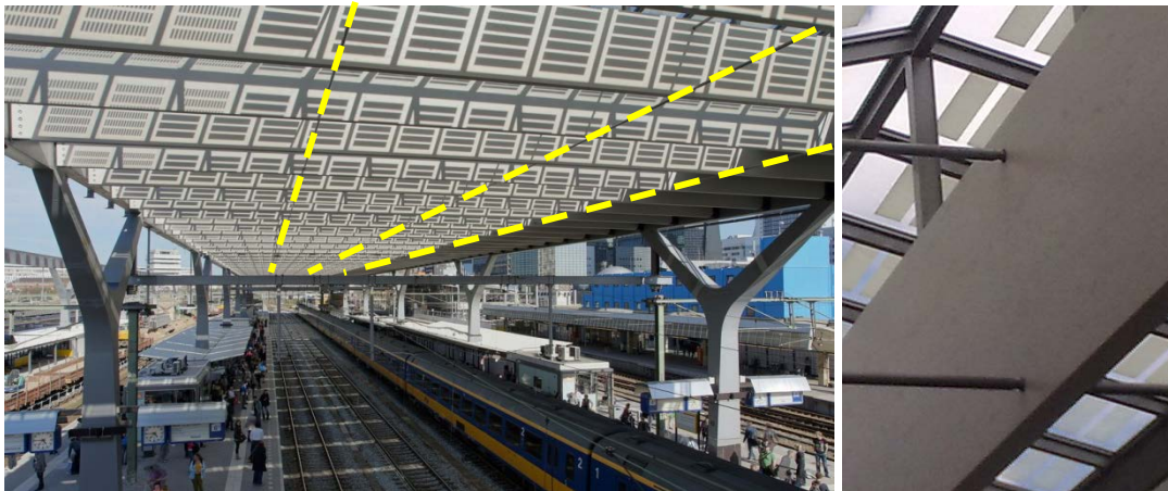
Figuur 6.34 Toepassing van zijdelingse kipsteunen bij de stationsoverkapping van Rotterdam centraal
